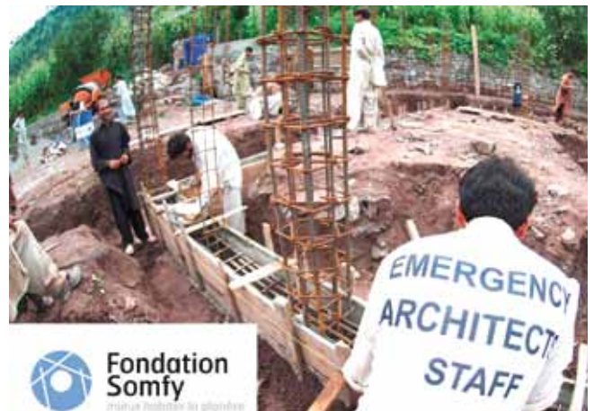
Chantier au Pakistan
